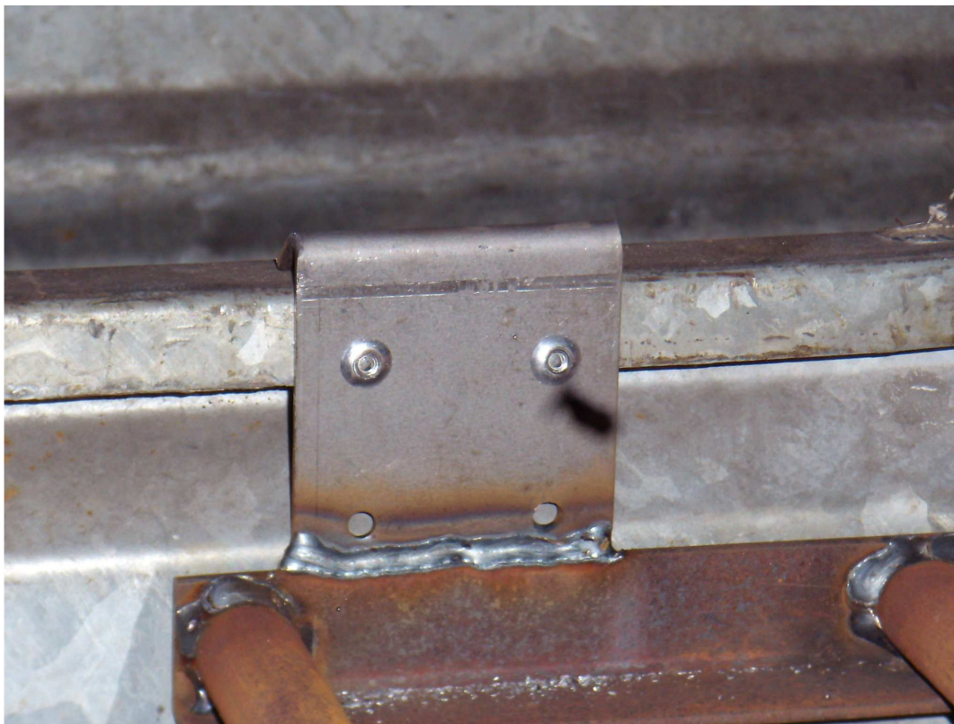
Fixation d'une patte de la grille de lanterneau
